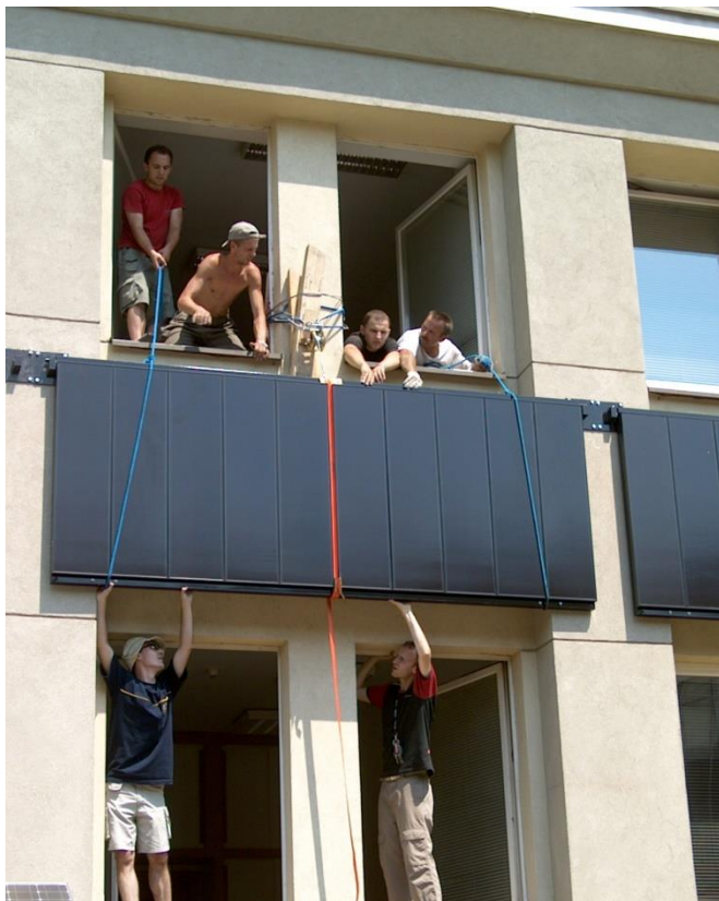
Budowa i uruchamianie fasady PV
