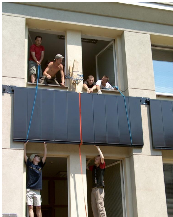
Budowa i uruchamianie fasady PV
